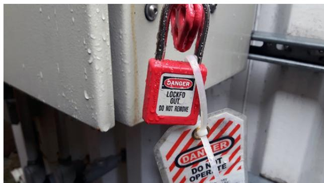
しかしながら、日本国内では、上記の規則が労働安全衛生法に定められているにも関わらず、機械装置を停止しないことによる災害、また、第三者が誤って機械装置を起動して被災する事故が多く発生しています。欧米では、ロックアウト/ダグアウトシステムが義務付けられており、ロックアウトが出来る機器、または、部品が一般的に販売されています。例えば、機械電気設備であれば、電源スイッチを OFF にした際に南京錠が取り付けられる構造のロックアウトスイッチが使用されます。また、“鍵をかける”に関しては、作業員自ら施錠し、その作業員が自ら開錠するまでは動力を再起動できないよう現場で運用されています。このロックアウト/ダグアウトシステムによって作業員自身が安全、かつ、安心してメンテナンスや保全作業に従事することができます。
